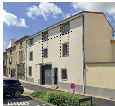
Exemple de réhabilitation / surélévation avec intégration des nouveaux percements dans la composition initiale de la façade
