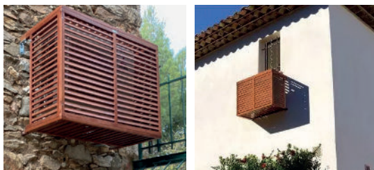
Exemple de dispositifs-écrans mis en place lors de l'adjonction de climatiseurs
