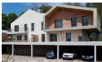
Etang-la-Ville - Des et stationnements permettant de limiter leur visibilité depuis les logements
