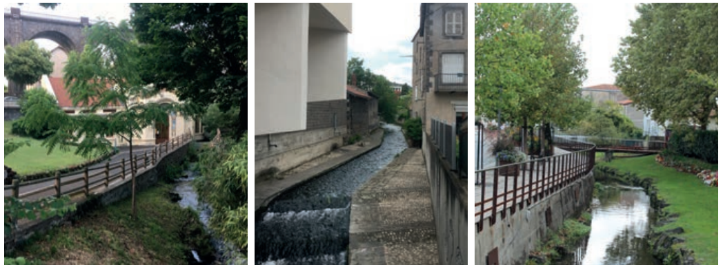
Cours d'eau en milieu urbain (Chamalières, Clermont-Ferrand, Cébazat)
