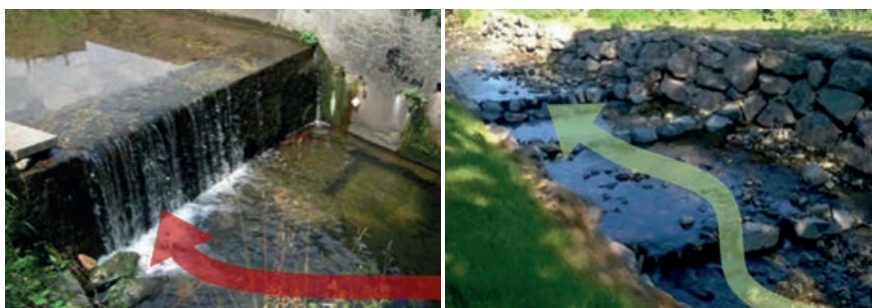
Exemples d'aménagements réalisés : modification du seuil de Pourliat sur la commune d'Aubière pour rétablir la continuité de l'Artière – AVANT seuil important et vertical, continuité écologique interrompue, APRES abaissement du seuil et création de seuils en escalier, amélioration des berges, continuité écologique rétablie (Source : © Association Rivière Rhône-Alpes Auvergne)
