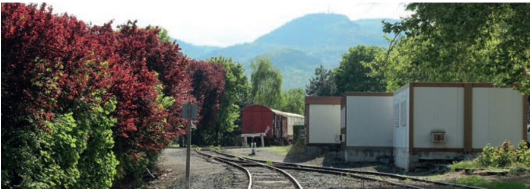
Les abords des voies ferrées à Clermont-Ferrand, un espace de projet pour créer un parc linéaire entre le centre-ville et les quartiers de Saint-Jean et du Brézet (Cf. OAP Projets).
