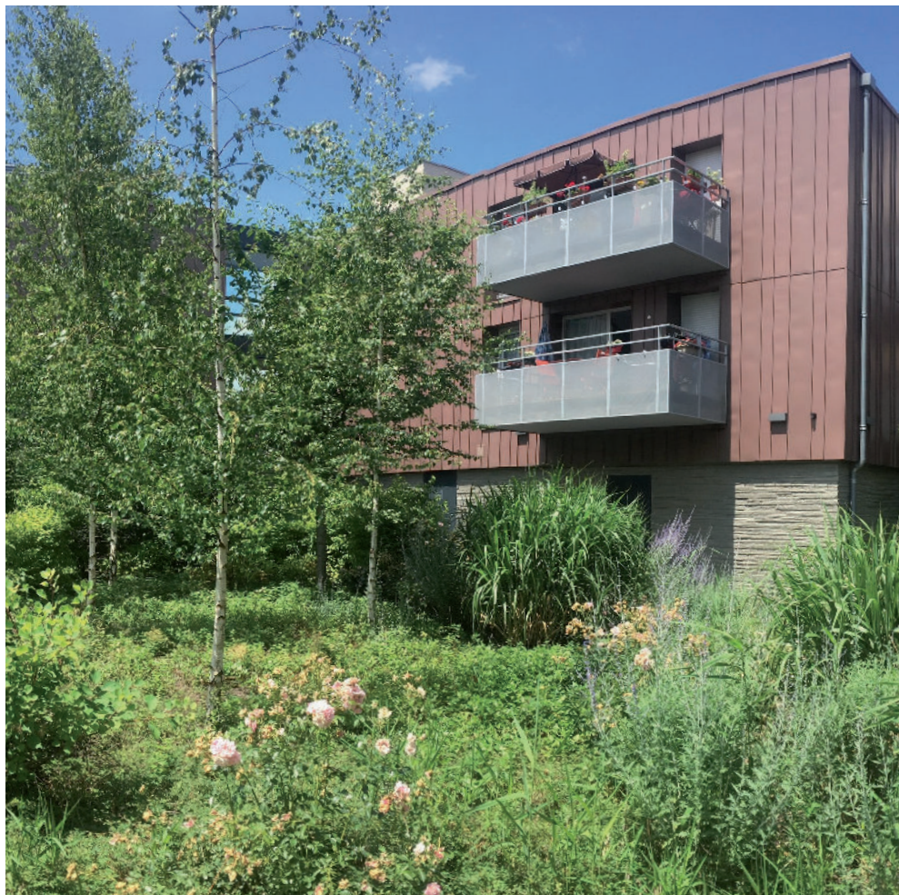
photo : opération de logements collectifs dans le centre bourg d'Aulnat
